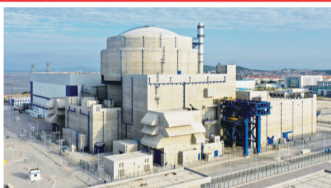
“华龙一号”示范工程福清核电6号机组
