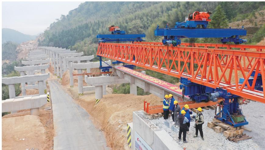
政永高速(德化段)首片预制T梁精准平稳地架设在溪美大桥支座上(林志灵 许华森摄)
