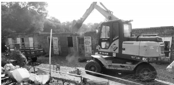
依法拆除违建养羊场
