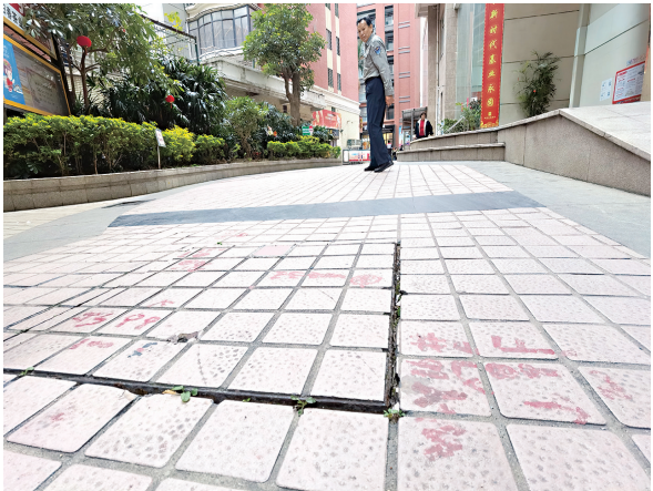
宏毅大厦小区已测量标记等待改造
