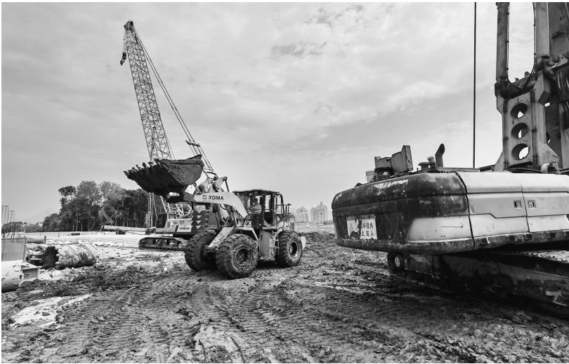
围挡内,两台桩机正在运转,现场一片火热
