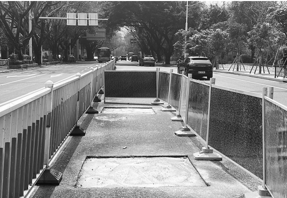
白马路杨桥路口的围挡
