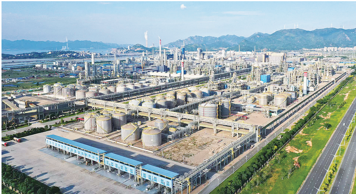
申远一体化产业园构筑起横跨化纤、化工、新材料领域的“产业王国”
