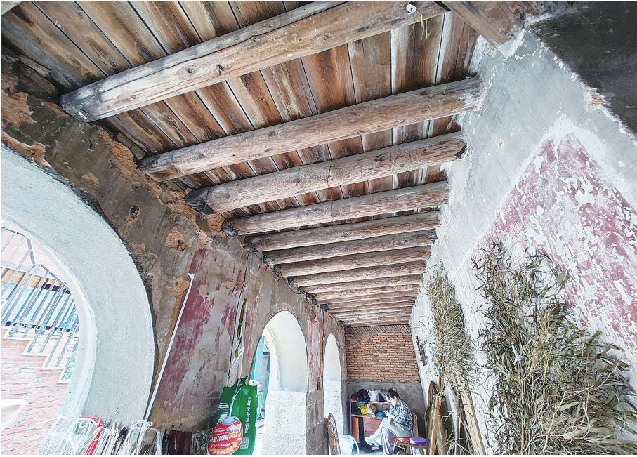
法国领事馆旧址的地下室外也形成了回廊,能隔绝地面潮气
