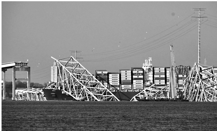
遭撞击后坍塌的“弗朗西斯·斯科特·基”大桥和撞击大桥的集装箱船
