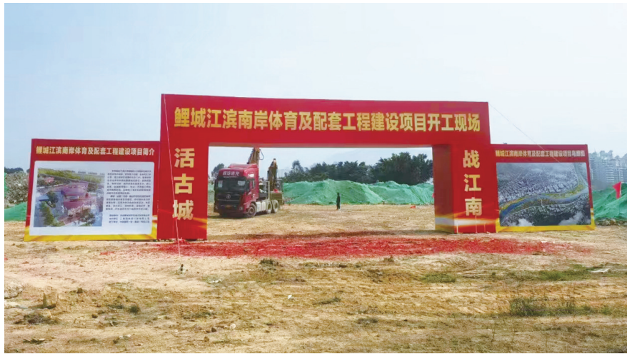
鲤城江滨南岸体育及配套工程建设项目开工,项目建成后将完善江南新区城市综合服务功能
