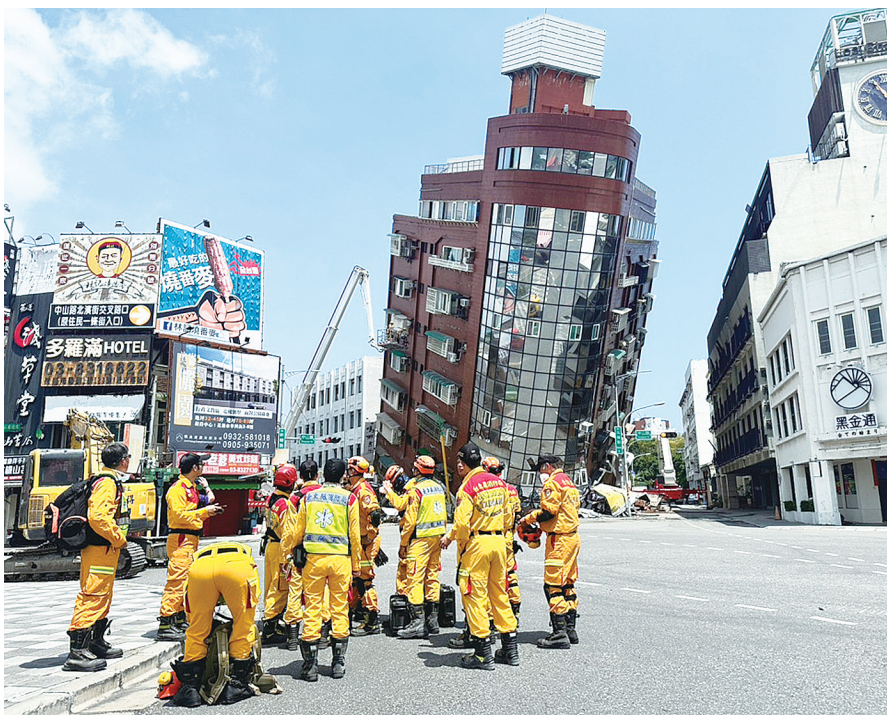
花莲一栋大楼在地震中严重倾斜
