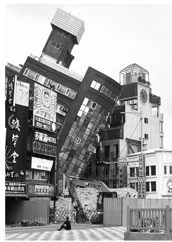
4月5日上午,花莲市区的天王星大楼准备由上至下进行拆除
