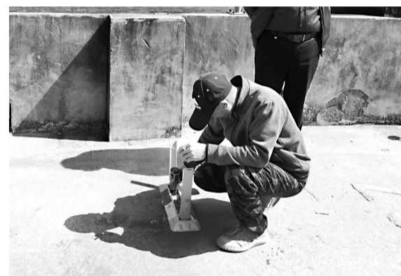
工作人员拆除停车场设备
