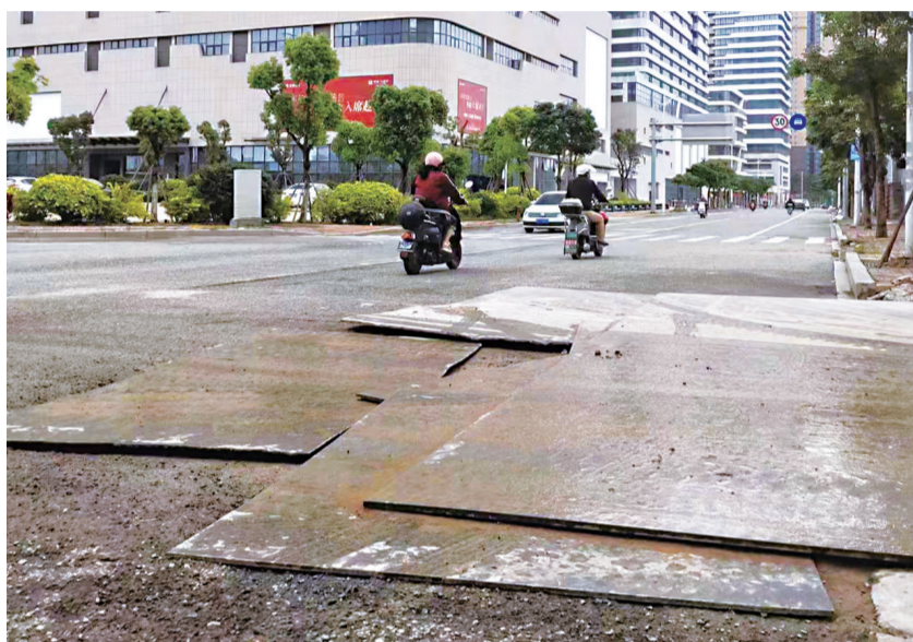
六块铁皮杂乱铺设,周围没有警示标识
