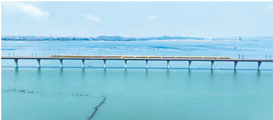
2023年6月28日,CR450动车组试验列车在湄洲湾跨海大桥交会运行(铁科院集团公司供图)
