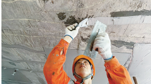
立交桥底部插入数十根“针管”
