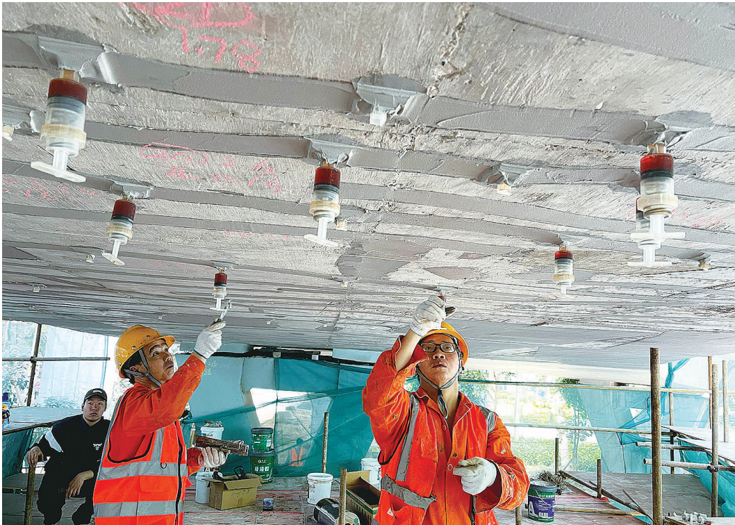
立交桥底部插入数十根“针管”
