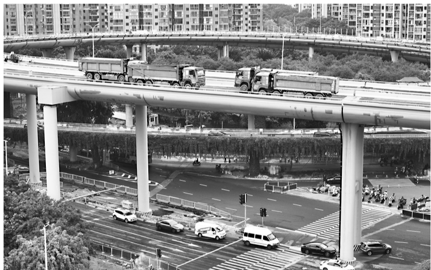
尤溪洲南立交匝道开展桥梁荷载试验
