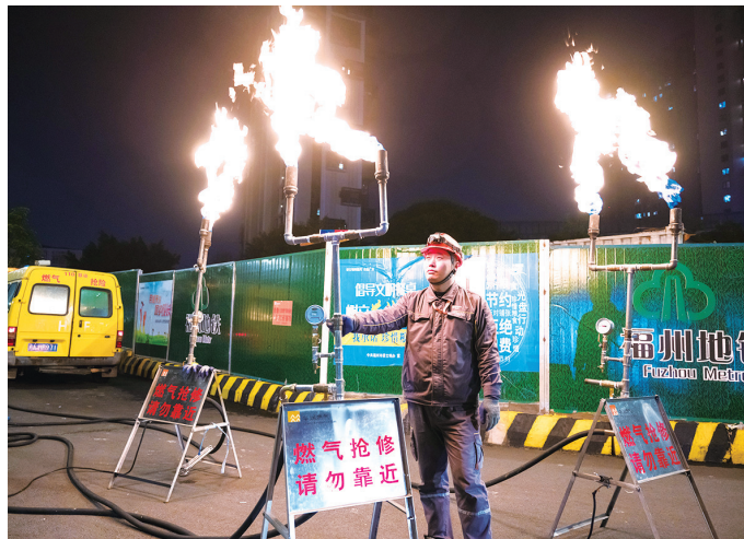
深夜里,管网施工员克服重重困难进行带气接驳作业
