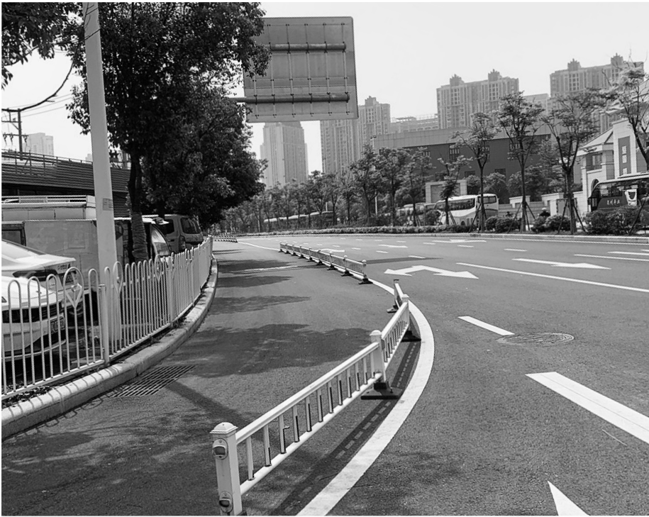
分隔非机动车道与机动车道的护栏,仅有约60厘米
