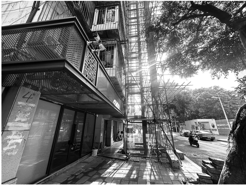
小区电梯加装在人行道上
