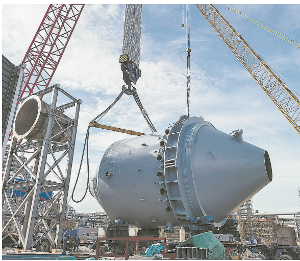
再生空气加热炉(首台套)的吊装过程 (受访单位供图)
