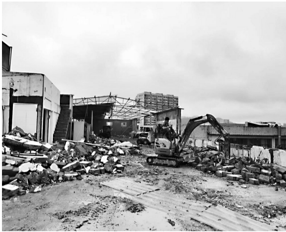
江南街道一酒店在拆除违建
