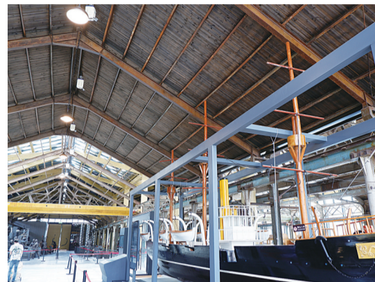
铁肺厂内保留完好的钢架结构
