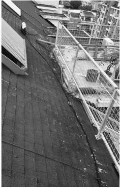
电缆从三号梯一直连接到四号梯
