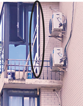
二楼业主将水管移至墙外
