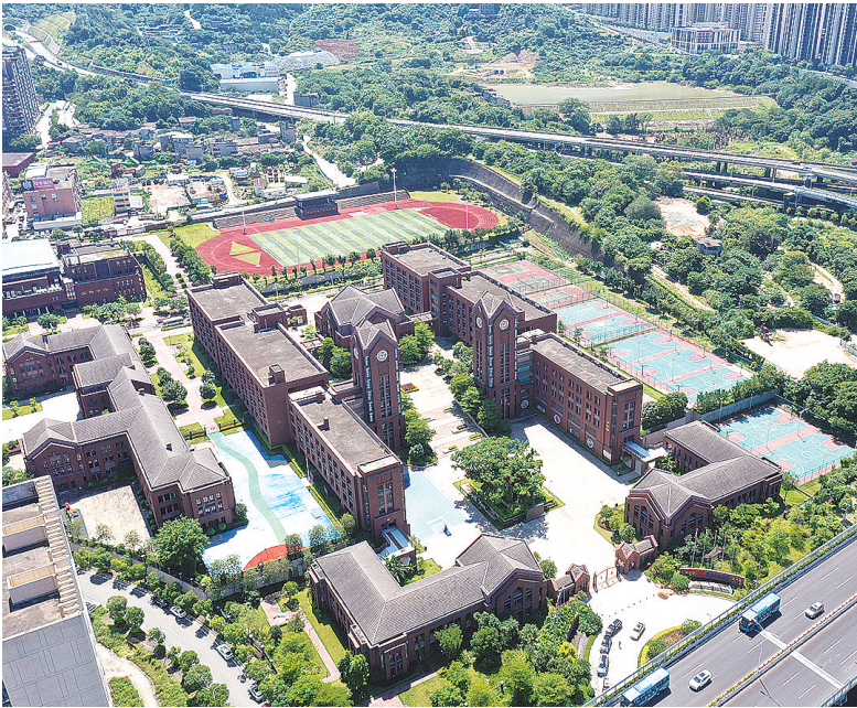
航拍福州中加学校
