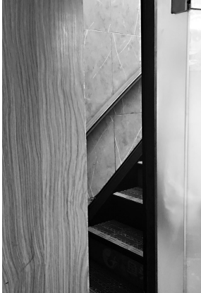
门店二楼通往101室包间的通道被用柜子挡住
