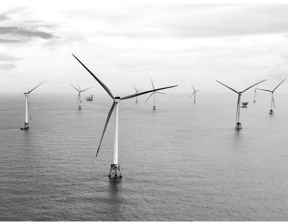
三峡集团漳浦二期海上风电项目现场(新华社/图)
