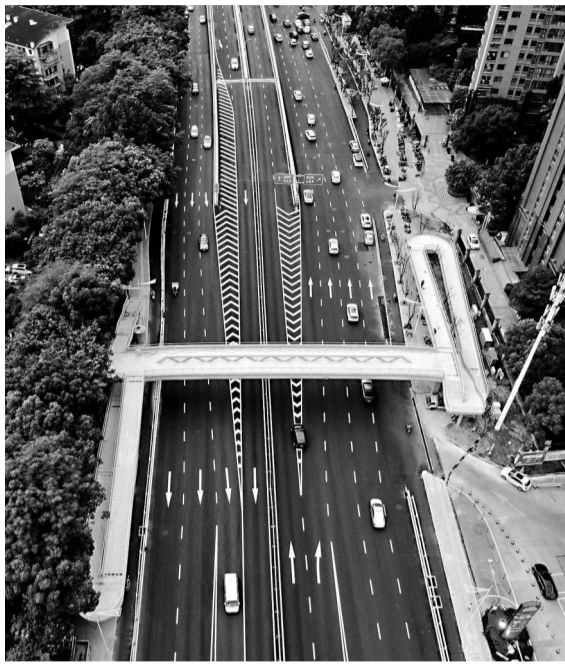
闽江大道过街天桥,设有双向坡道及双梯道,可满足行人和非机动车出行需求
