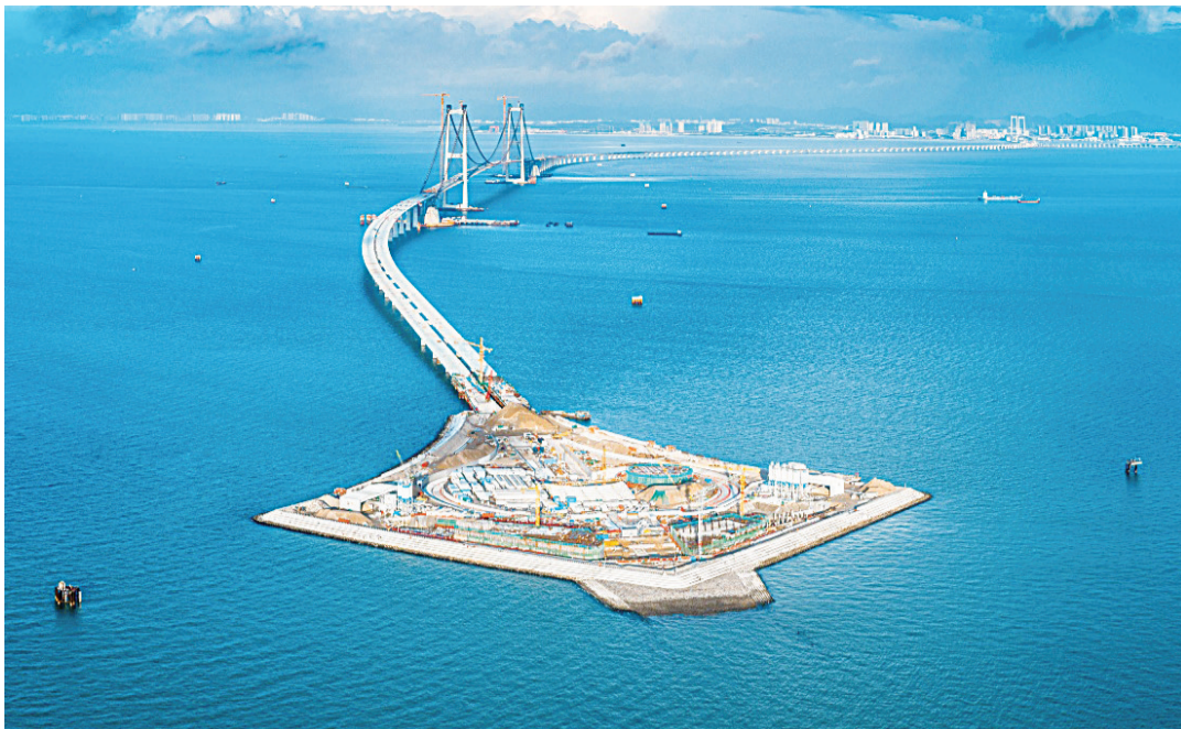
2023年6月20日拍摄的建设中的深中通道西人工岛(新华/图)
