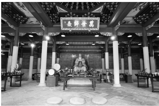
南安文庙复建工程项目竣工
