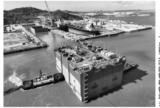
一点四万吨的锚碇钢沉井
