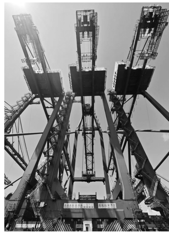
自动化远控岸桥投入运行
