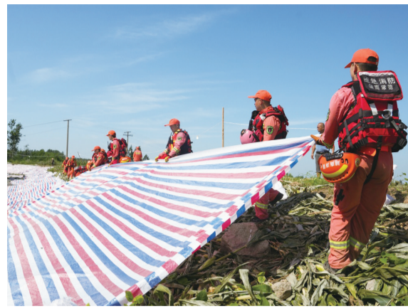
▲7月7日,抢险人员在钱团垸堤修复和加固彩条布(新华图)
