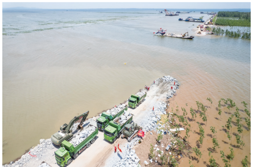
7月7日,在湖南省岳阳市华容县团洲垸洞庭湖大堤决口现场,抢险队伍在进行堵口作业(新华图)
