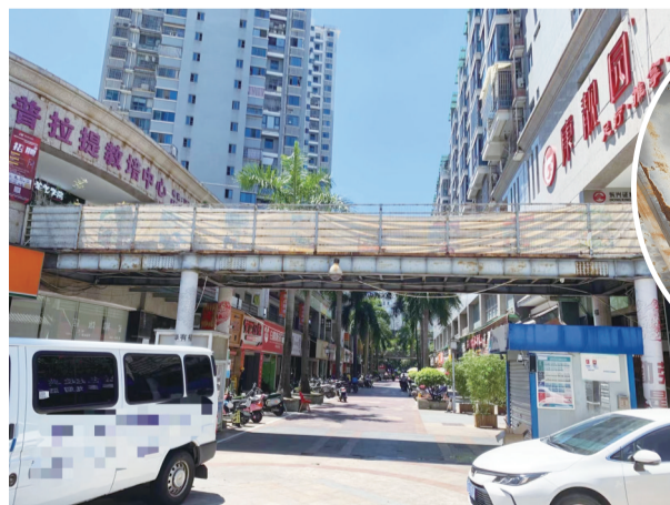
天桥的底部铁板已经布满锈迹,还因锈蚀出现小孔洞
