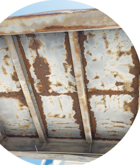
天桥的底部铁板已经布满锈迹,还因锈蚀出现小孔洞
