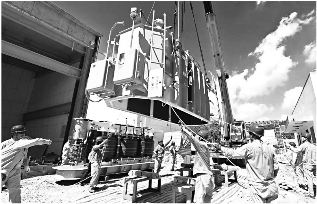
▲7月5日,福建亿力集团所属福建亿兴集团自主施工完成泉州地区电网迎峰度夏项目110千伏河市变电站2台变压器主变吊罩检查工作
