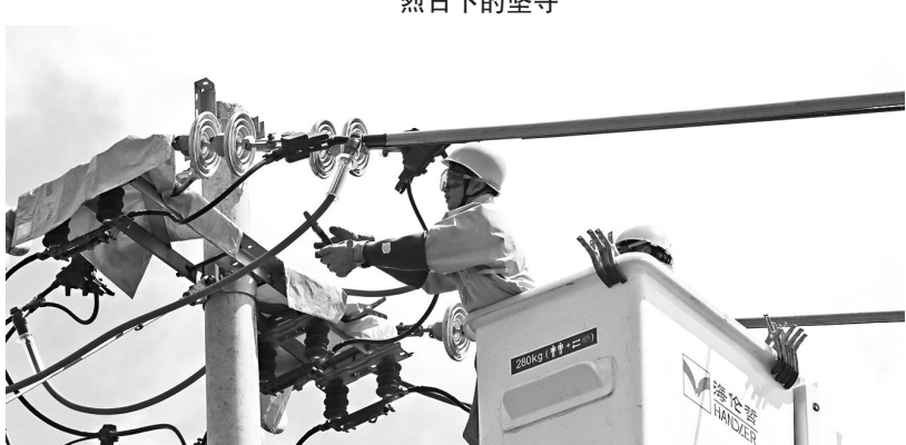
龙岩瑞源公司连城分公司带电作业班在10千伏内山线64号杆开展带电作业
