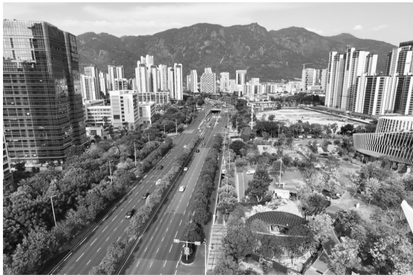
化工路将进行交通导改,人行道和绿化带将硬化成路面
