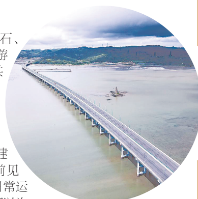
国道G228漳州段漳江湾特大桥航拍
