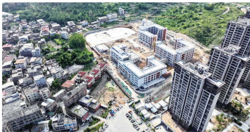
四幢房屋拆除后,家长接送孩子将更加便利(黄奕群摄)
