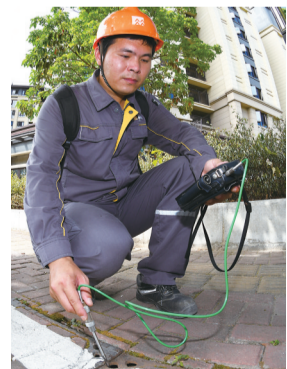
吴师傅每天巡线80公里,使用专业设备监测燃气管道是否安全
