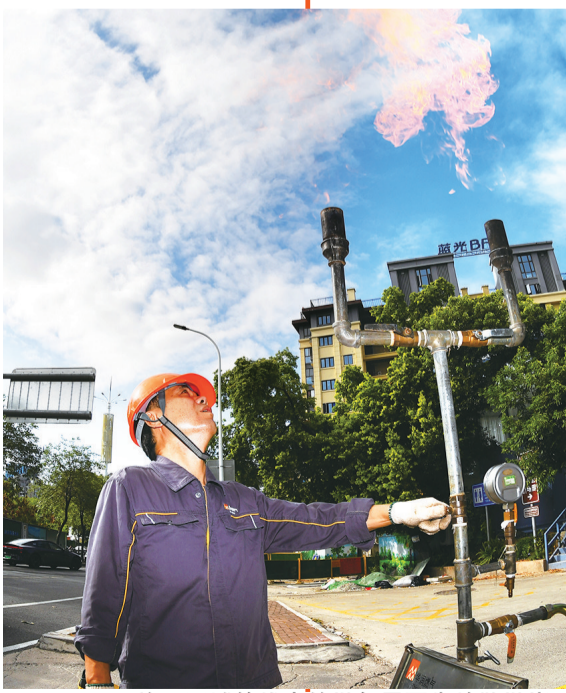
施工区域管线内的燃气需要先放散燃烧,烈焰旁的温度至少升高10℃
