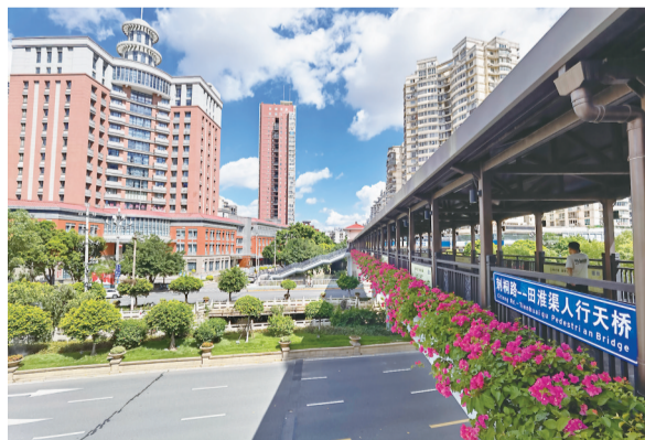
这是泉州首座电梯天桥
