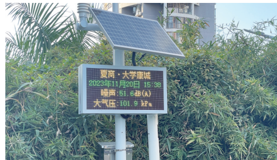
小区内设有全天候的噪声监控系统
