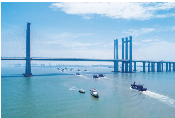
航拍福厦高铁泉州湾跨海大桥(泉州海事局供图)
