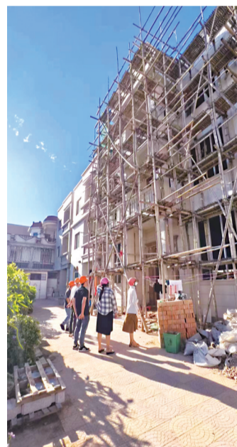
检查房屋安全
