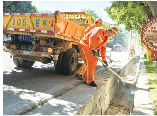
及时清理疏通公路两侧水沟
