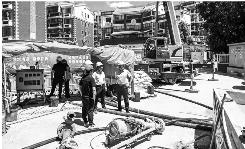
南俊路(东街—二郎巷)市政提升工程施工现场
