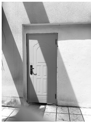
天台上被砌墙装上铁门
