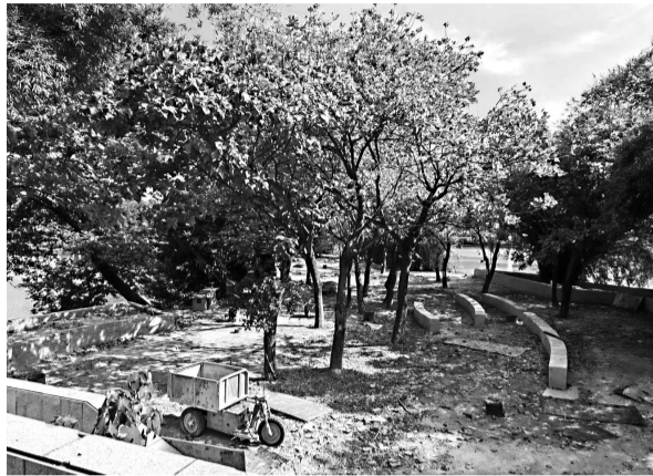
孔雀岛上的石凳、树池等设施已经搭建完成
