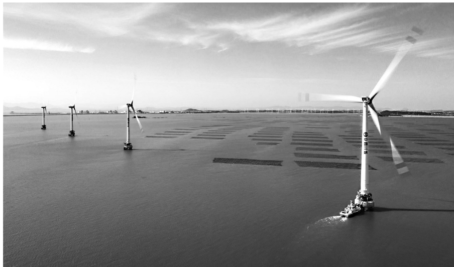
位于江阴半岛的超级“大风车”,将丝丝海风化为清洁绿电(高扬/摄)
