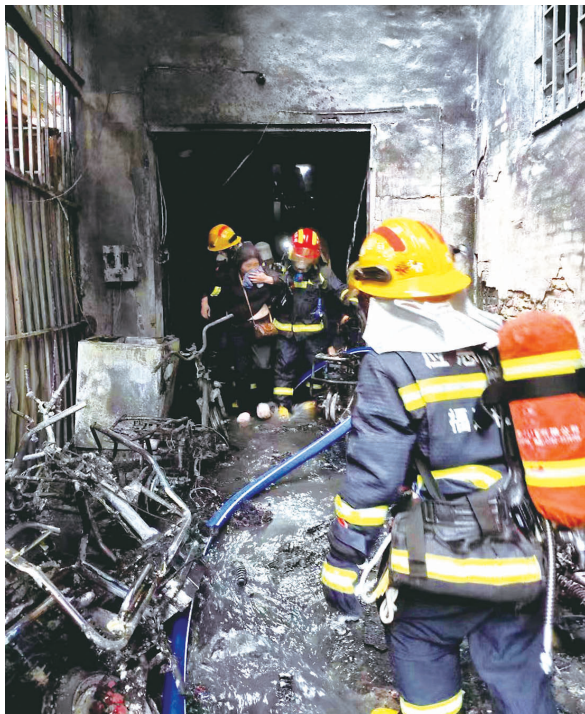
在仓山区盖山镇,因电动自行车起火,自建房被烧得一片狼藉
