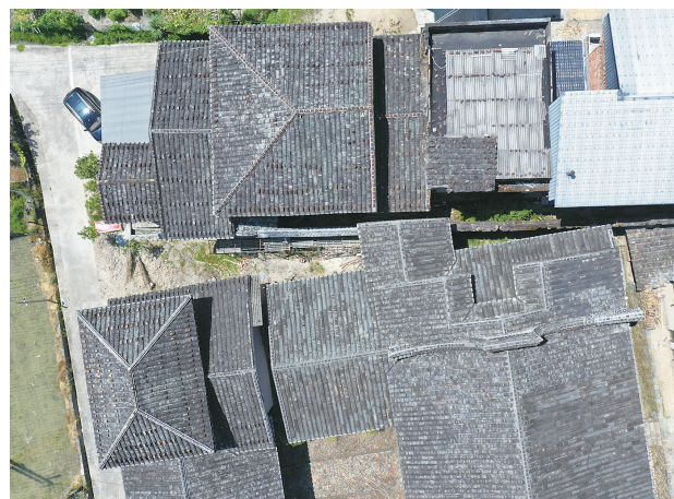
航拍火墙厝,大部分瓦墙已修缮
